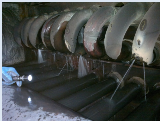
شکل ۵- تیوب های خورده شده از کویل k
