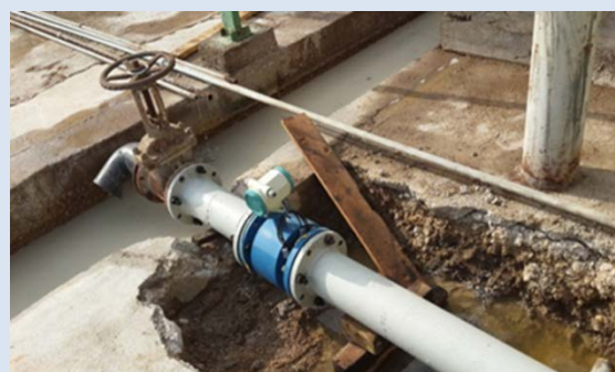
شکل ۴- محل نصب فلومتر در کولینگ تاور واحد نیروگاه
